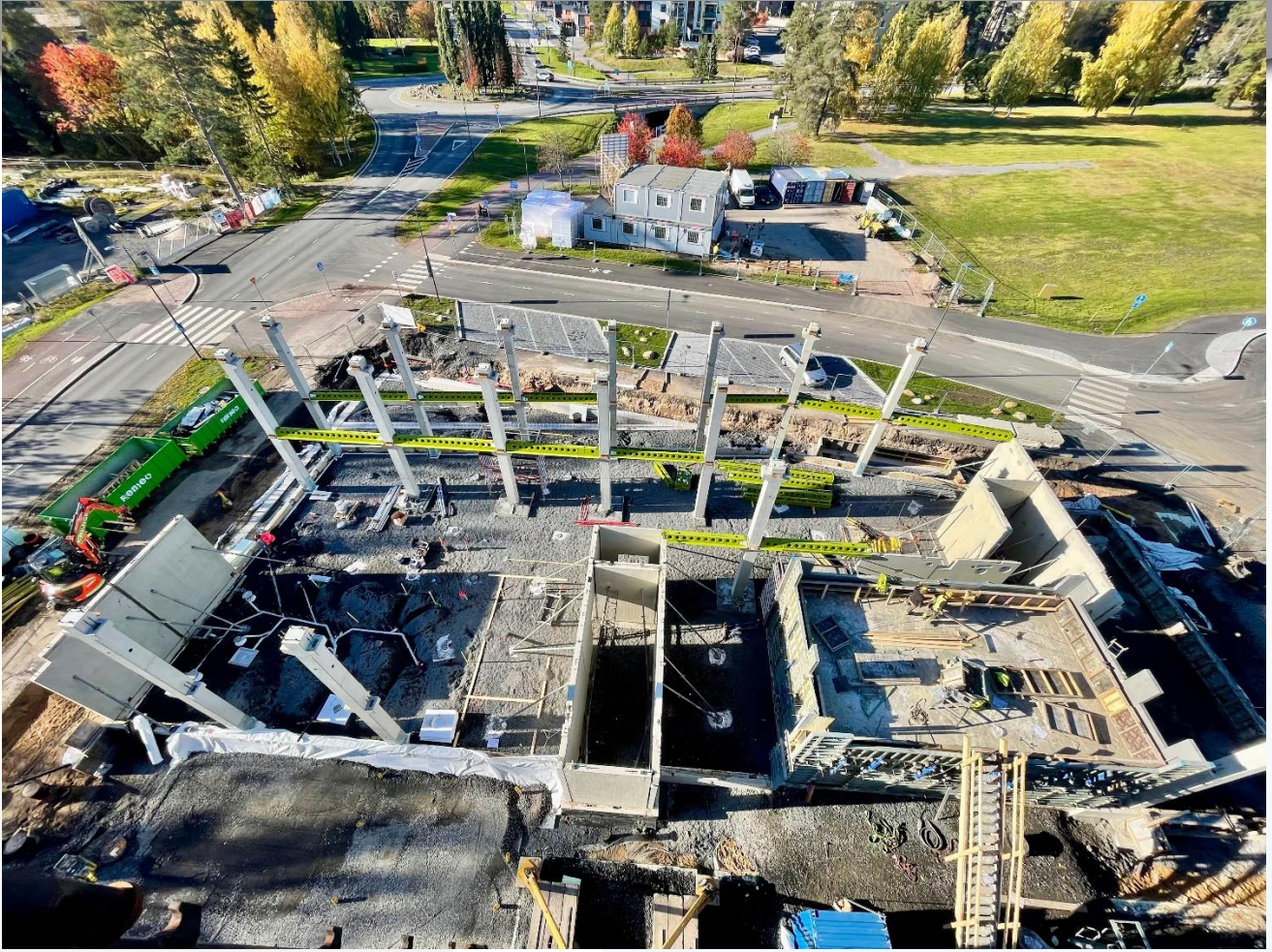
Ensimmäisen kerroksen kantavaa runkoa
