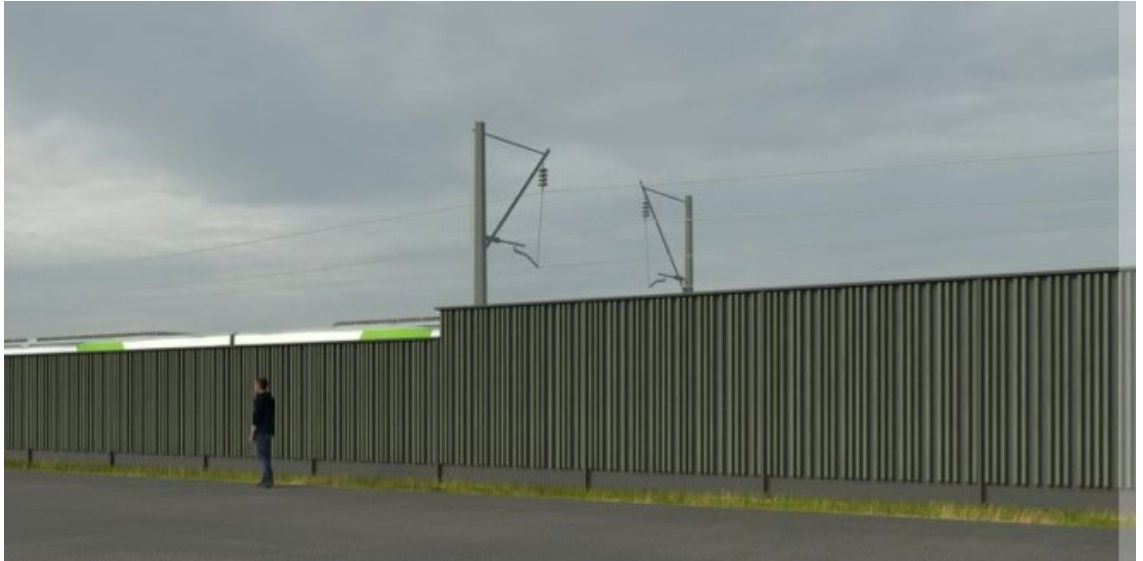
Kuva 2. Havainnekuva meluseinästä, jonka ulkopinta rimoitettu
