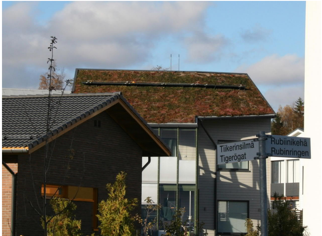
Kuva 4. Maksaruohokattoa Vantaan asunomessujen omakotitalossa 2015.
