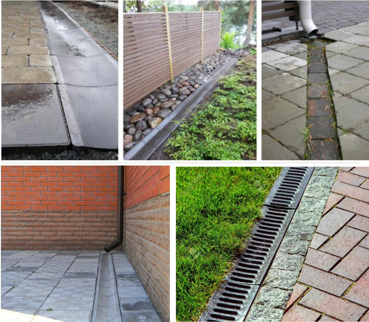
Kuva 3.3.1. Esimerkkejä erilaisista koururakenteista. Ylhäällä kourulaatta, vesikouru ja astetta pintaa syvemmälle asennettu betonikiviraita laatoituksen keskellä. Alhaalla vesikouru, sekä ritilällä peitetty koururakenne.
