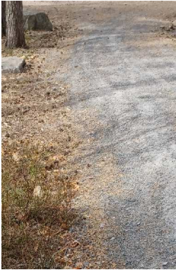
Kivituhka-alueiden luiskat pinnoitetaan kivituhkalla h=50mm ja viimeistellään liittyväksi nykyiseen maanpintaan niin, että profilointimurskeet eivät näy ja sen irtokivet eivät tule esiin.
